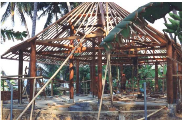
Dies sind Fotos aus der Bauphase unserer Villen und des Lumbungs in Ciliks Beach Garden Tragende Holzstrukturen, Bambus und Alang-Alang (Reetgras) sowie einige eingesetzte Wände
