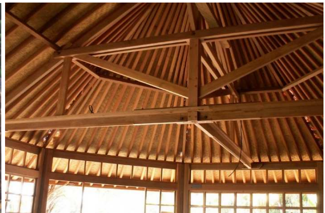
Dies sind Fotos aus der Bauphase unserer Villen und des Lumbungs in Ciliks Beach Garden Tragende Holzstrukturen, Bambus und Alang-Alang (Reetgras) sowie einige eingesetzte Wände
