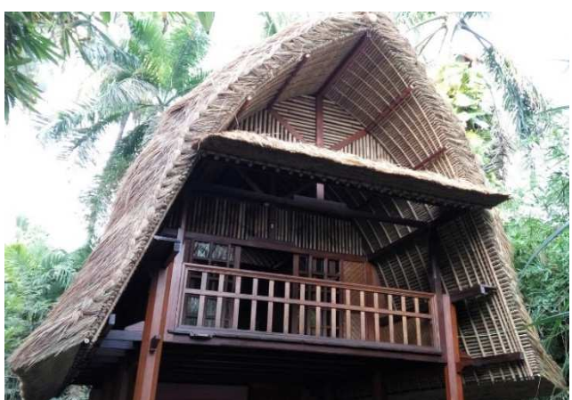
Dies sind Fotos aus der Bauphase unserer Villen und des Lumbungs in Ciliks Beach Garden Tragende Holzstrukturen, Bambus und Alang-Alang (Reetgras) sowie einige eingesetzte Wände
