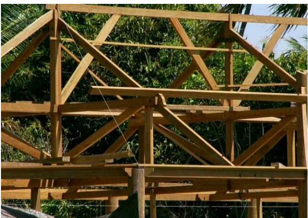
Dies sind Fotos aus der Bauphase unserer Villen und des Lumbungs in Ciliks Beach Garden Tragende Holzstrukturen, Bambus und Alang-Alang (Reetgras) sowie einige eingesetzte Wände
