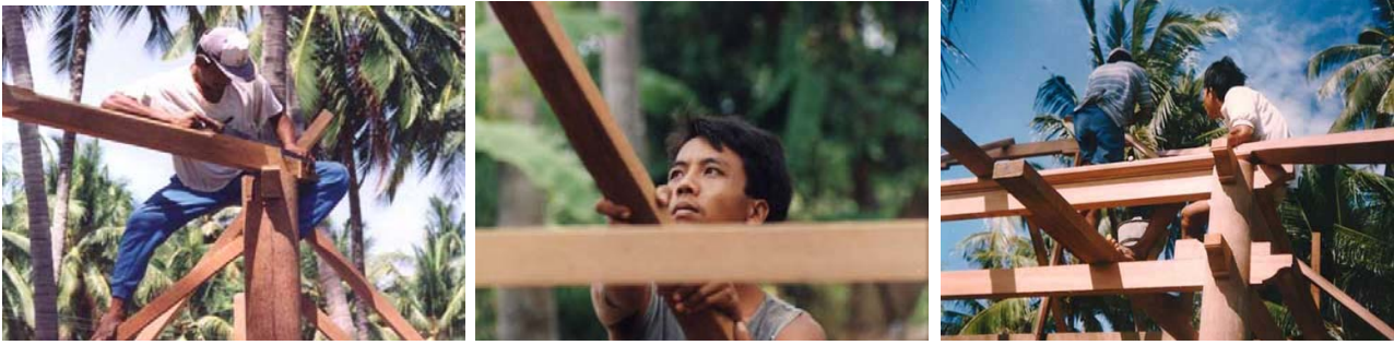
Gearbeitet wurde mit Handwerkern der Umgebung, ganz ohne Maschinen und mithilfe traditioneller Techniken
