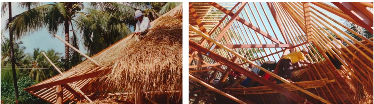
Das filigrane Bambusnetz des bis in den First offenen Dachstuhls, gedeckt von luftigem along-alang Gras
