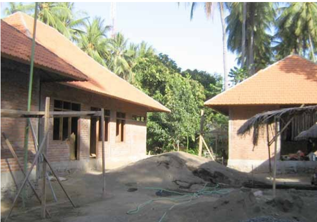
Die Baustelle im August: Küchen- und Wohngebäude
