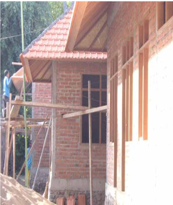
Die Baustelle im September
